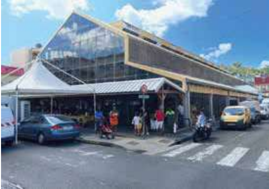
Le marché couvert de Fort-de-France
